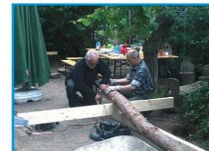
Holzarbeiten für die Pergola
